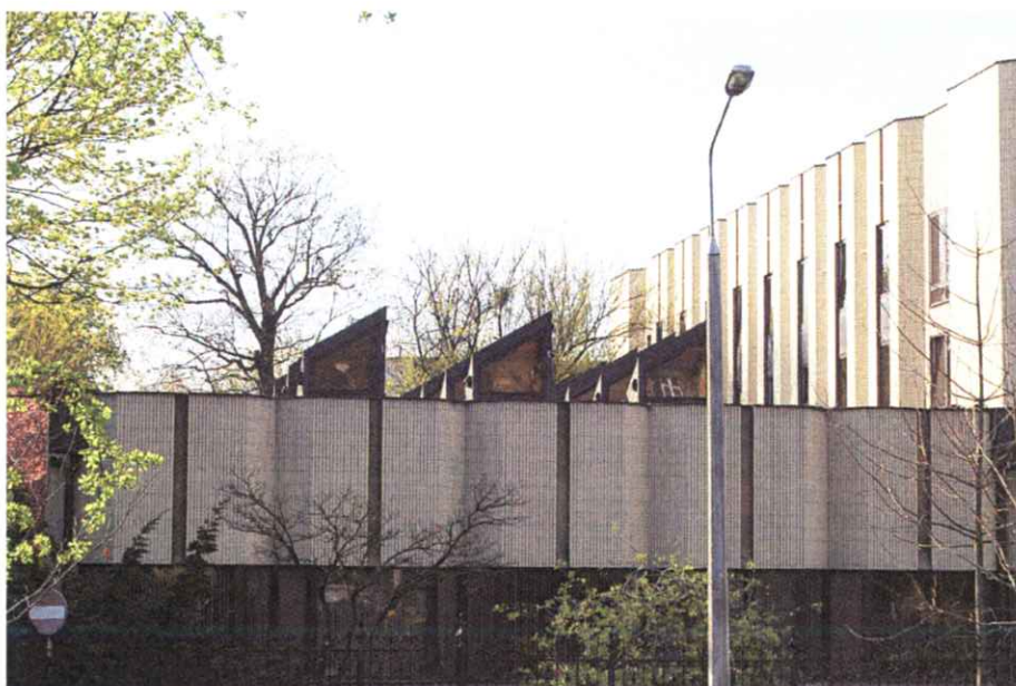
budynek C – widok świetlików dachowych
