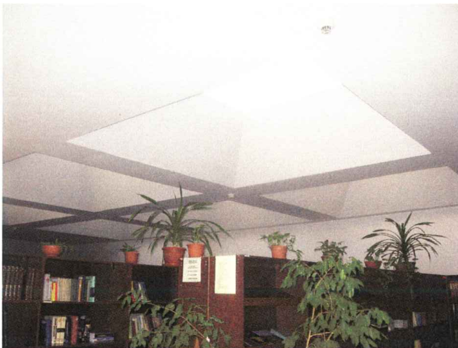
wnętrze biblioteki – świetliki dachowe
